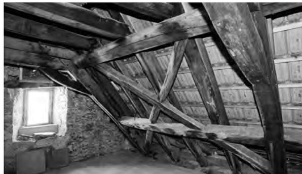
Abb. 8: Eichener Dachstuhl von 1544 mit gebogenen Kopfstreben
