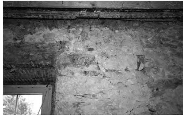
Abb. 2: Alter Stichbogen im Erdgeschoss Saalbau
