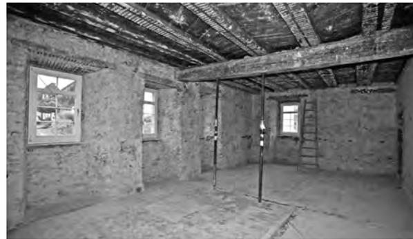
Abb. 3: Unterzug in Ost-West-Richtung im Untergeschoss
